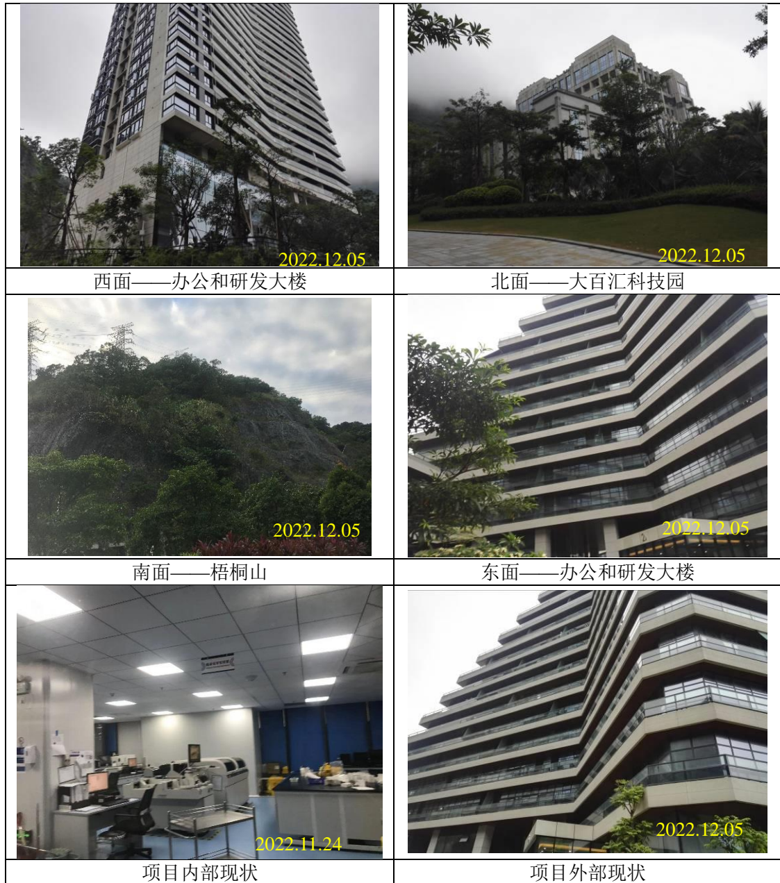
附图 4 项目厂房外观和车间内现状
