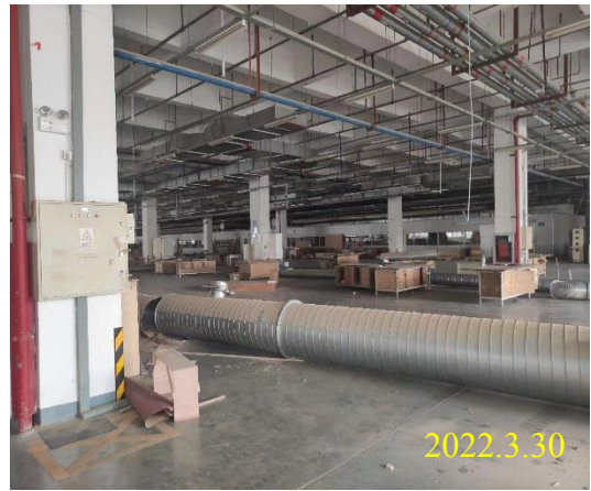
项目车间现状
