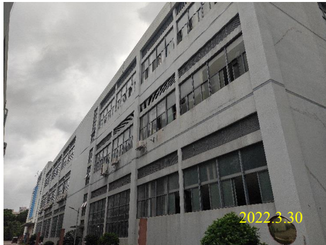
西面同栋厂房
