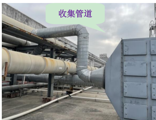
项目收集管道项目
